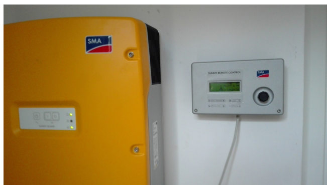
Фиг. 4 Автономен инвертор SMASI-6,0 (6000 W) с дистанционен контрол.
