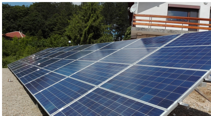
Фиг. 5 Автономна фотоволтаична система 10 kW с хибридна схема.
